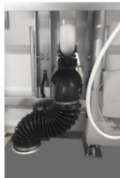
**d2.** Si le drain est dans le **mur**, monter le soufflet de vidange dans le siphon mural, monter les supports fournis sur le mur, de sorte que la bride de la toilette soit maintenue en place
