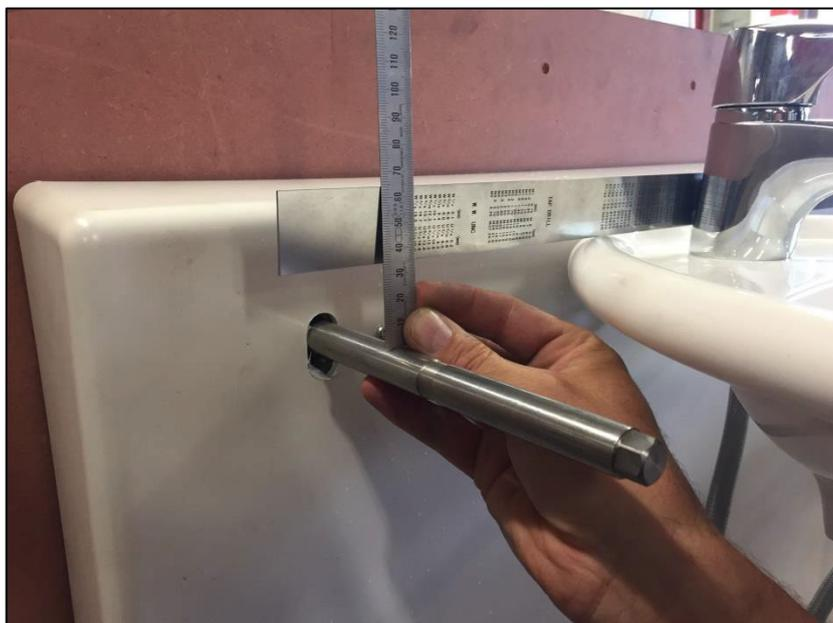
Tourner le lavabo contre le couvercle. Placer si possible un niveau à bulle sur le lavabo. Pour que la fixation de la station se fasse à la bonne hauteur, desserrer légèrement les raccords et les ajuster de manière à laisser un espace d'environ 1,5 m de large. 33 mm entre les raccords et le niveau à bulle. Ensuite, fixez soigneusement les raccords à l'aide d'une clé à molette.
